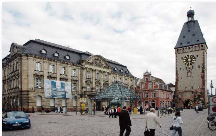
Das Gebäude der ehemaligen Post in Speyer
